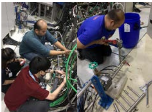
รูปที่ 3 งานประกอบ และติดตั้งชุดข้อต่อน้ำหล่อเย็นบริสุทธ์ ของระบบแม่เหล็ก ภายในวงกักเก็บอิเล็กตรอน
