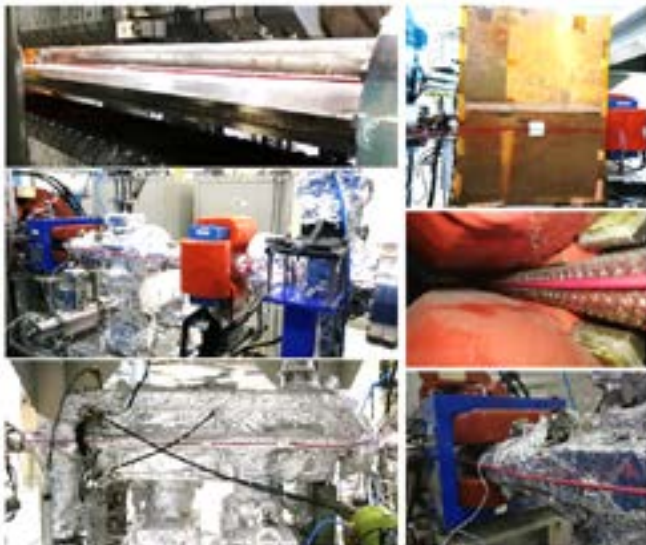
รูปที่ 12 การติดตั้งสาย optical fiber (สายสีแดง) ข้างท่อสุญญากาศบริเวณต่าง ๆ
