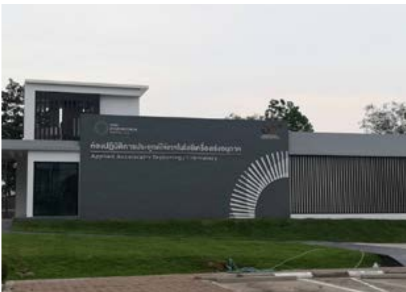
รูปที่ 46 ควบคุมงานก่อสร้างอาคารห้องปฏิบัติการประยุกต์ใช้เทคโนโลยีเครื่องเร่งอนุภาค
