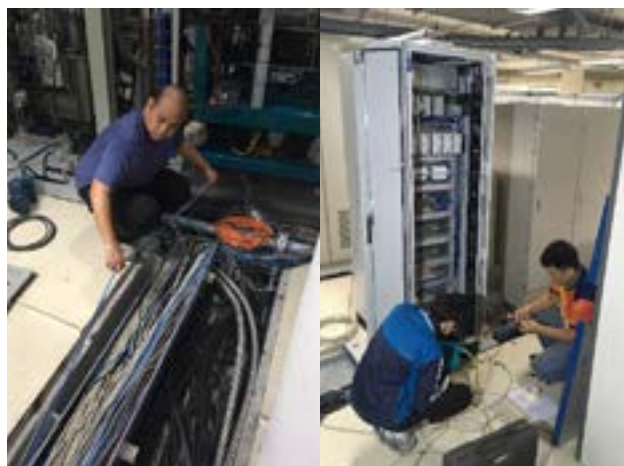
รูปที่ 4 งานเดินสายไฟฟ้า สายสัญญาณ และติดตั้งตู้ควบคุม ระบบ ภายในวงกักเก็บอิเล็กตรอน
